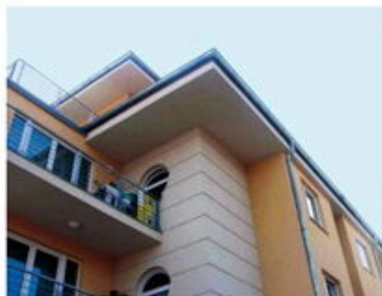
Imaginea 139. Detaliu al cornișei cu streășină a clădirii
