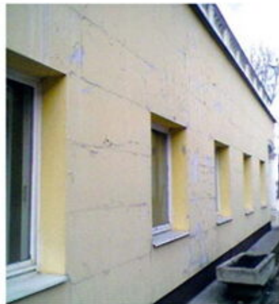
Imagina 181. Prin fisurări se pot observa liniile de racord ale plăcilor termoizolante
